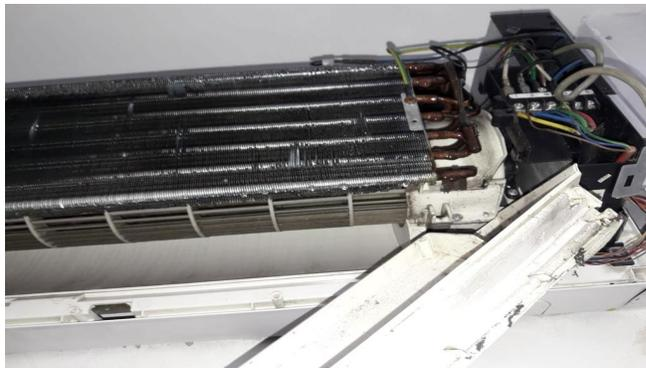
11. Se realizó limpieza de sus partes internas y externas. Adicional se hace un diagnóstico de sus piezas y elementos a intervenir o cambiar en el próximo mantenimiento.
