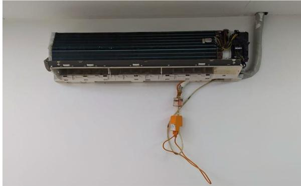
2. Se realizó limpieza de sus partes internas y externas. Adicional se hace un diagnóstico de sus piezas y elementos a intervenir o cambiar en el próximo mantenimiento.
