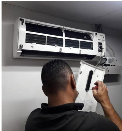
5. Se realizó limpieza de sus partes internas y externas. Adicional se hace un diagnóstico de sus piezas y elementos a intervenir o cambiar en el próximo mantenimiento.
